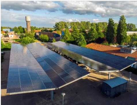
Carport met zonnepanelen voor het opwekken hernieuwbare elektriciteit en het laden van elektrische wagens (© Amar Sjauw En Wa)
