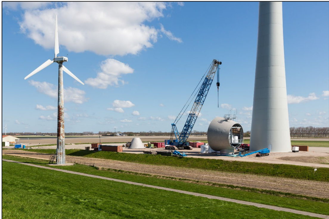
Figuur 3.1 Windturbine in aanbouw (Foto: Shutterstock)
